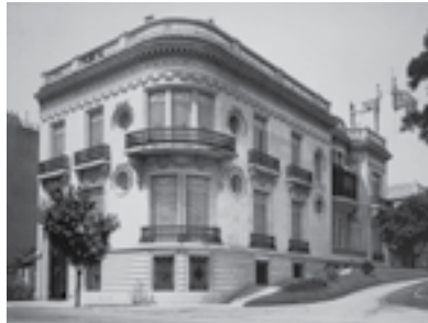
Edificio de vivienda particular ubicado en la Avenida Alvear.
