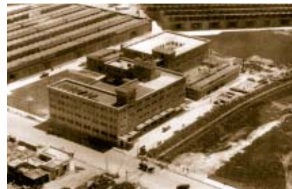
Vista aérea de la fábrica de pinturas “Alba”, Pompeya, hacia 1930
