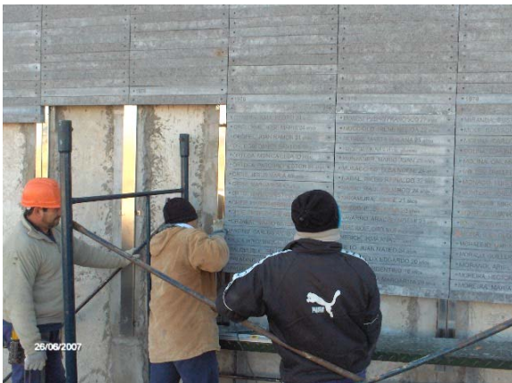
Nivelación y colocación de placas
