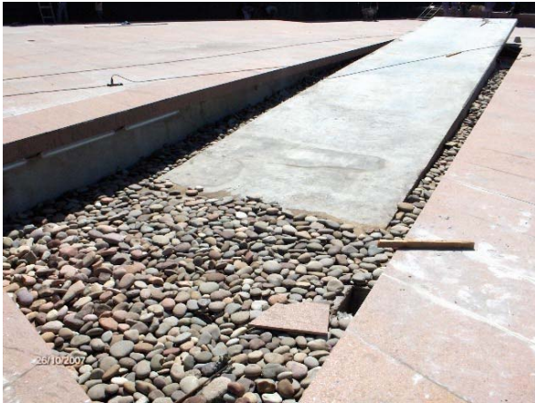
Losa en voladizo
